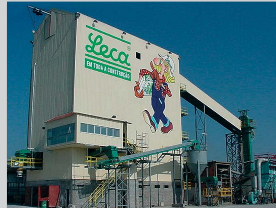
Komplet højsiloanlæg med indtag og materialefordeling på siloloft samt udlevering til lastbil.
