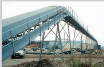
Landføringsanlæg for sten- og grusmaterialer.
